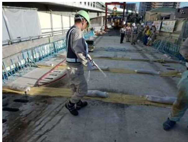
写真－解 4.11 場所打ち UFC の養生事例（間詰め部）
