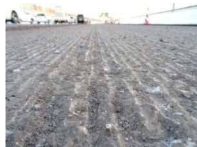
(a) 大型切削機による舗装撤去 (b) 残存した床版防水層の除去 (c) 過切削された RC 床版上面 写真一解 2.1 大型切削機等による床版の過切削状況
