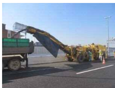
(a) 大型切削機による舗装撤去 (b) 残存した床版防水層の除去 (c) 過切削された RC 床版上面 写真一解 2.1 大型切削機等による床版の過切削状況
