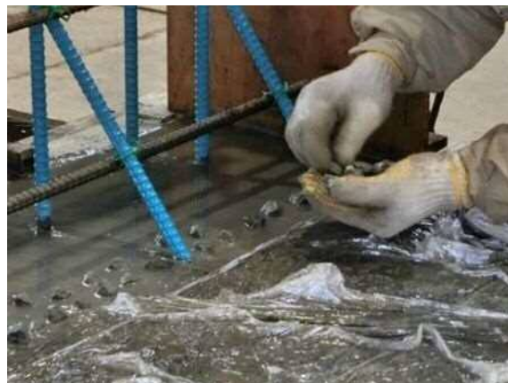
写真一解 4.10 打継ぎ目処理の事例（高欄打継部）
