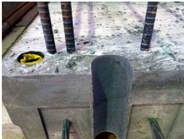
写真一解 3.2 半割のずれ止め用孔
