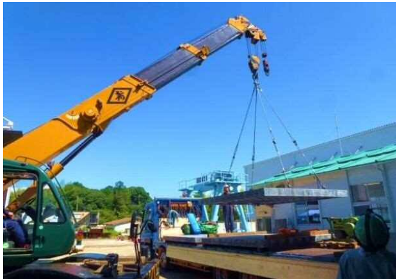
写真一解 4.5 ワッフル型 UFC 床版の吊上げ状況
