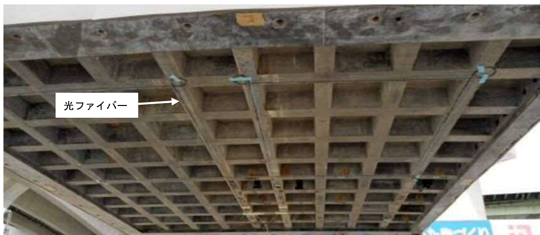
写真一解 5.1 光ファイバー設置状況
