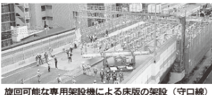
旋回可能な専用架設機による床版の架設(守口線)
