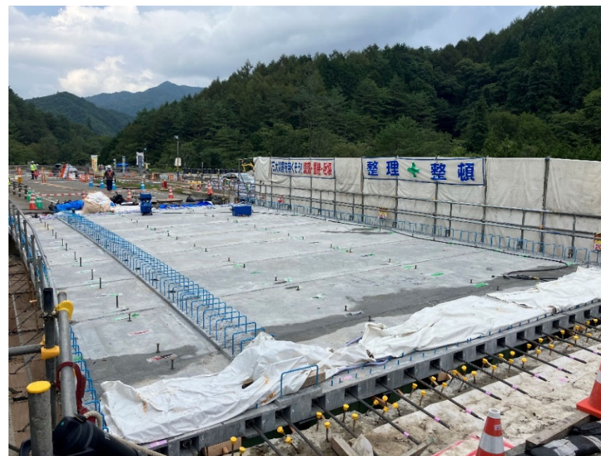
PC鋼より線の緊張完了
