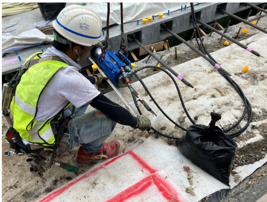
PC鋼より線の緊張状況
