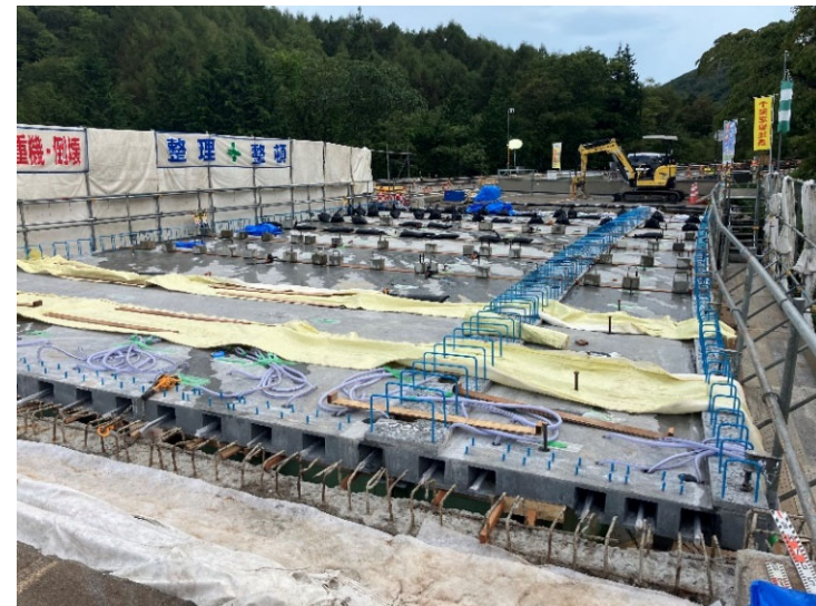
打設完了および養生
