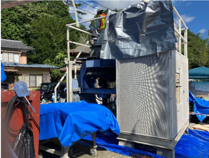
場所打ちUHPFRCの練り混ぜ
