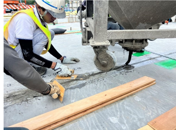
場所打ちUHPFRCの打設
