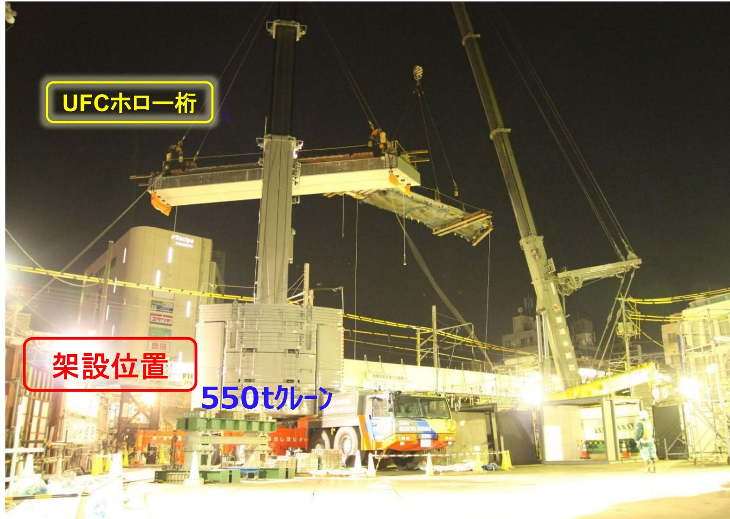
UFCホロー一桁の架設状況
