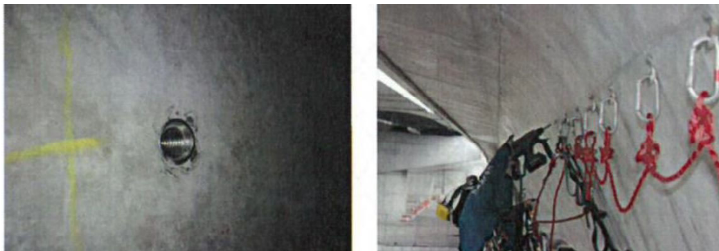
図一解 3.30 特殊高所作業におけるアンカーの設置状況（例）
