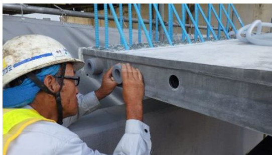
写真一解 4.8 シールスポンジの設置状況
