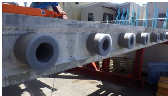
写真一解 4.8 シールスポンジの設置状況
