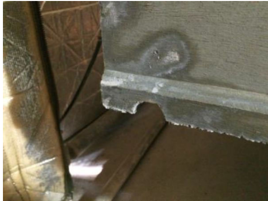
写真一解 3.3 水切り構造（例）
