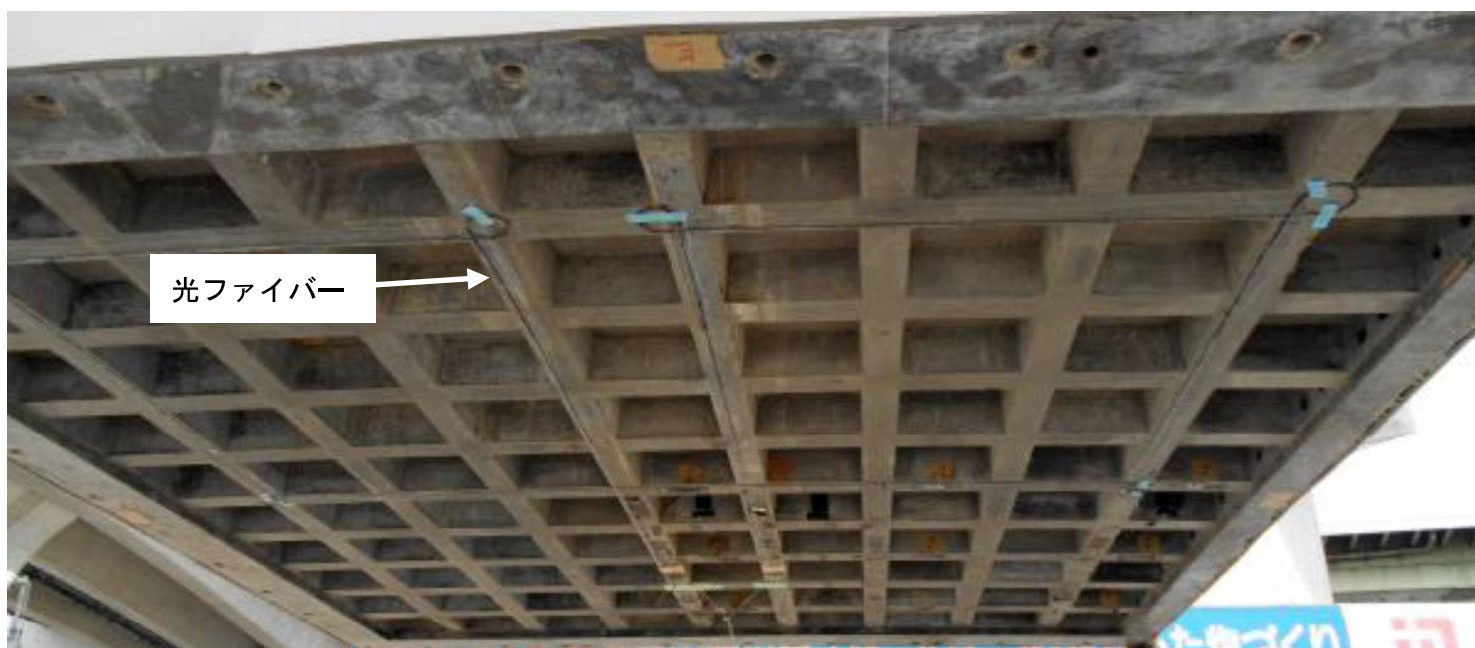
写真一解 5.1 光ファイバー設置状況
