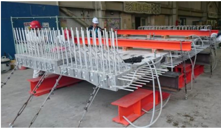
写真一解 4.9 場所打ち部との接続用の鉄筋配置例
