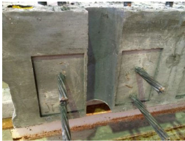
写真一解 3.2 半割のずれ止め用孔
