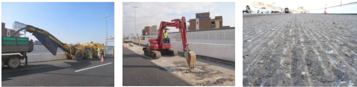
(a) 大型切削機による舗装撤去 (b) 残存した床版防水層の除去 (c) 過切削された RC 床版上面 写真一解 2.1 大型切削機等による床版の過切削状況
